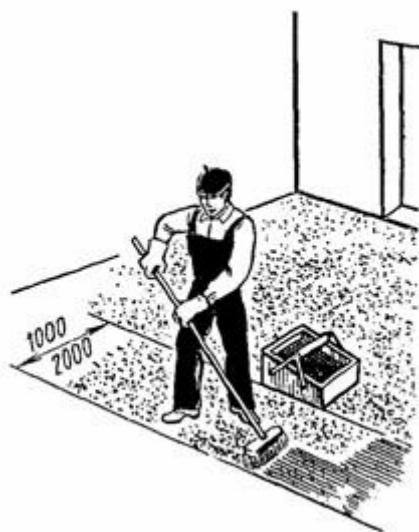
Рис. 72. Нанесение восковой мастики щеткой
