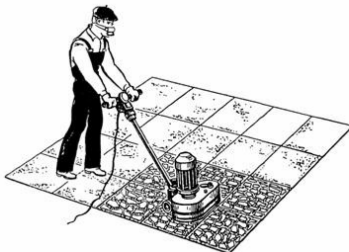
Рис. 71. Шлифовка мозаичного покрытия
