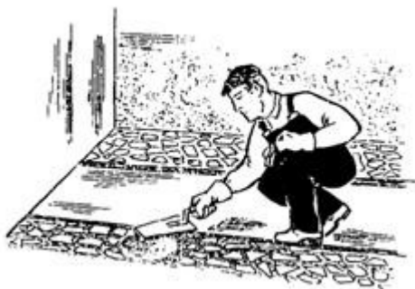
Рис. 61. Выравнивание мозаичной смеси в полосах-захватках растворной лопаткой
