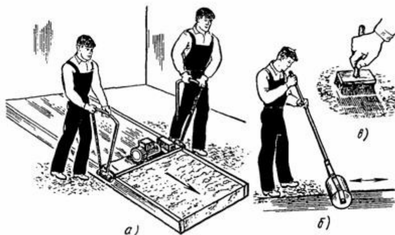
Рис. 62. Уплотнение мозаичной смеси:
