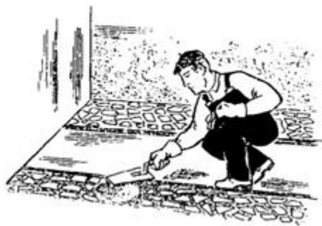
Рис. 61. Выравнивание мозаичной смеси в полосах-захватках растворной лопаткой
