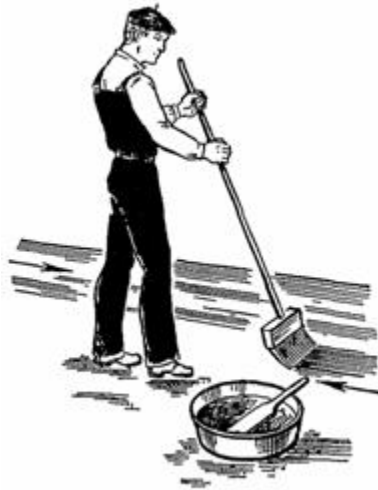
Рис. 87. Отделка лицевого слоя лаком
