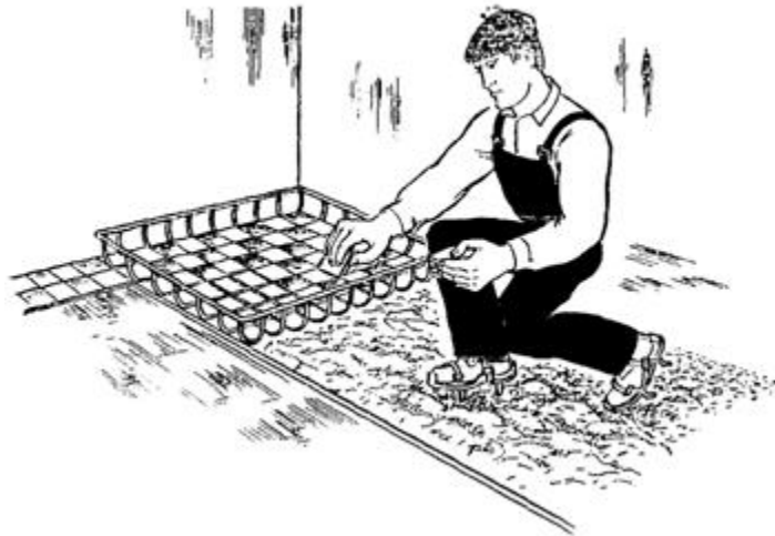
Рис. 34. Настилка пола с помощью клеточного шаблона
