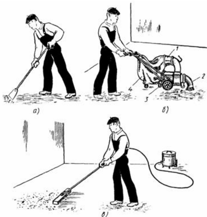
Рис. 47. Очистка и обеспыливание основания:
