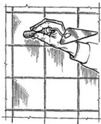
Рис. 107. Выявление отслоившихся плиток
