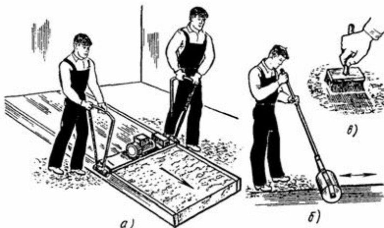
Рис. 62. Уплотнение мозаичной смеси:
