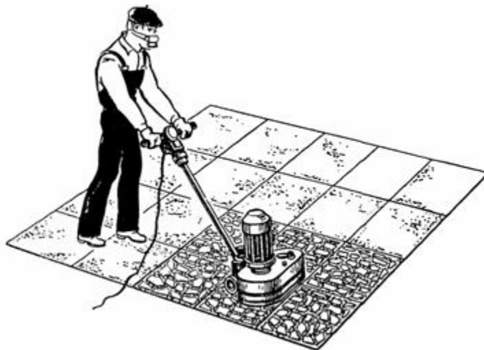
Рис. 71. Шлифовка мозаичного покрытия
