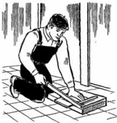
Рис. 53. Заготовка неполномерных плиток гильотинными ножницами
