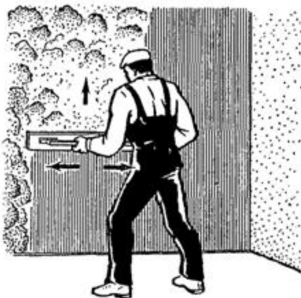
Рис. 94. Разравнивание раствора полутерком
