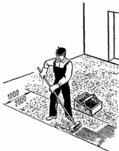
Рис. 72. Нанесение восковой мастики щеткой
