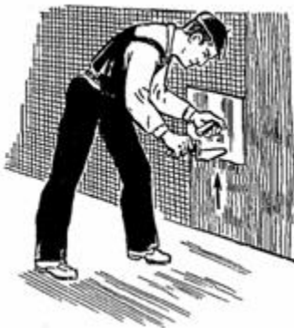
Рис. 90. Нанесение штукатурного раствора на стальную сетку
