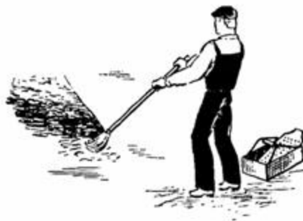
Рис. 48. Огрунтовка основания
