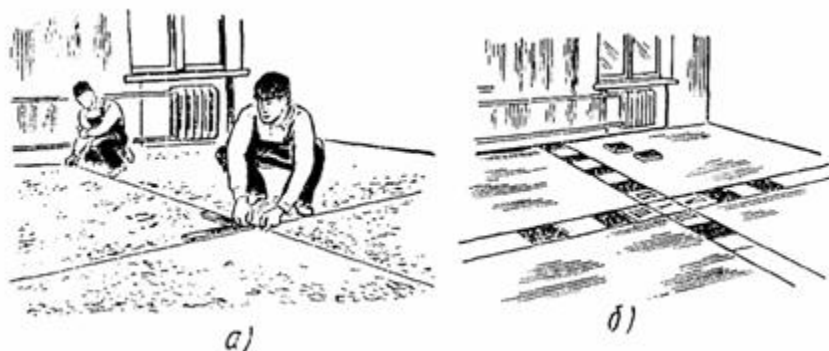
Рис. 49. Разметка и укладка маячных рядов:
